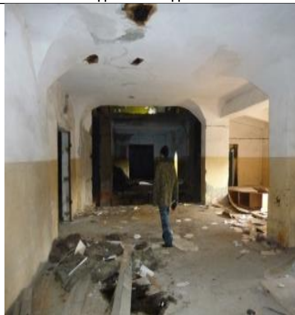
Фото 2.4. Здание холодильника лит Б
