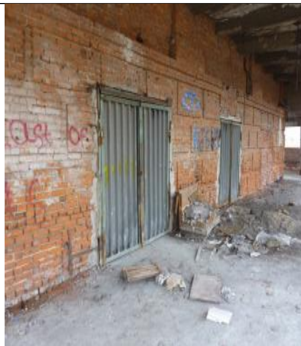
Фото 2.2. Здание холодильника лит Б
