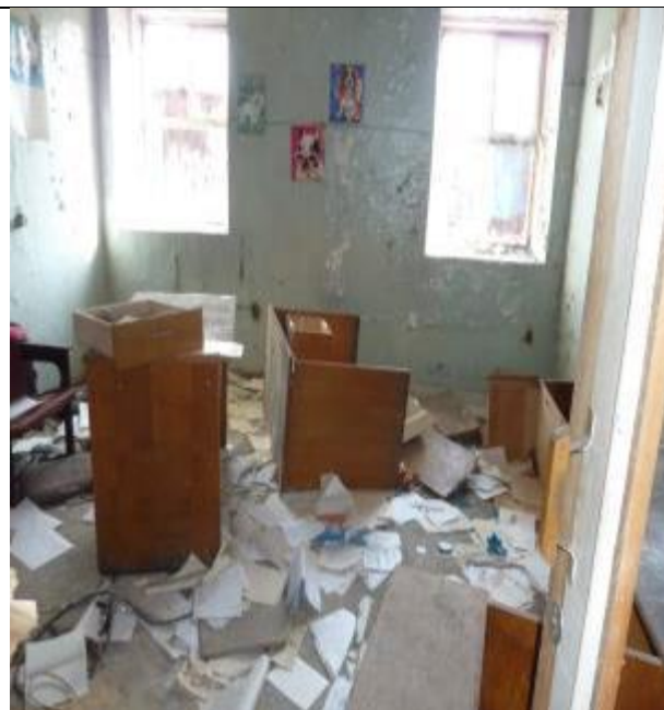
Фото 2.6. Здание холодильника лит Б
