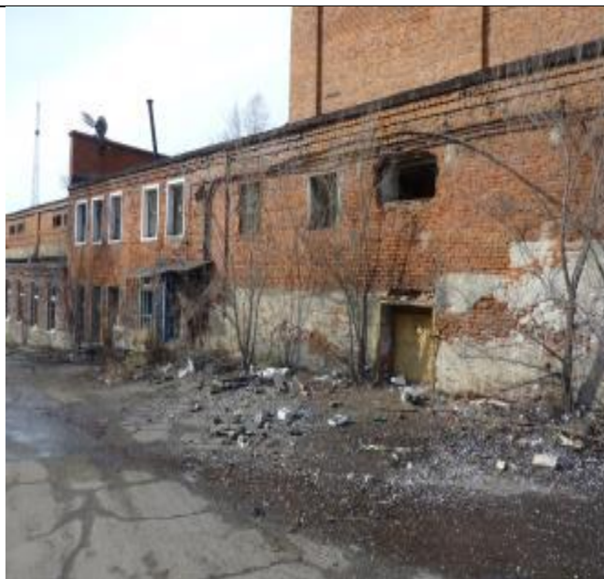
Фото 2.3. Здание холодильника лит Б
