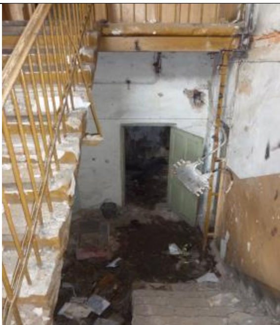
Фото 2.5. Здание холодильника лит Б
