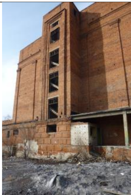
Фото 2.1. Здание холодильника лит Б
