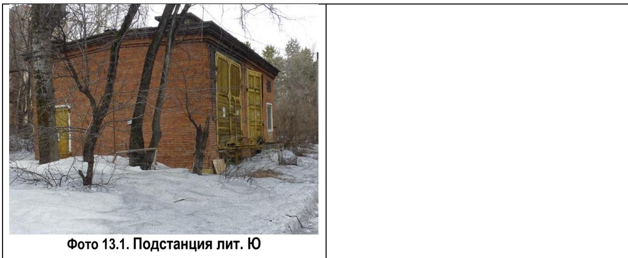
Состояние ветхое, средний износ 80%, сети отключены, отопление отсутствует.
