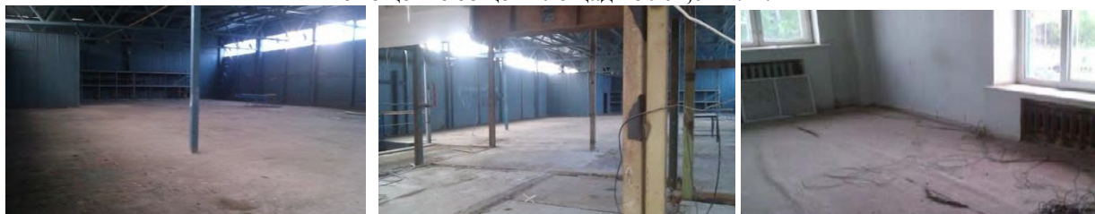
Помещение общей площадью 388 кв. м.
