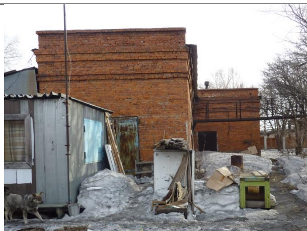
Фото 1.2. Центральная распределительная подстанция, лит. О
