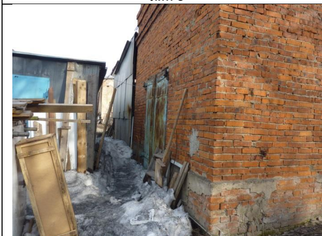
Фото 1.3. Центральная распределительная подстанция, лит. О
