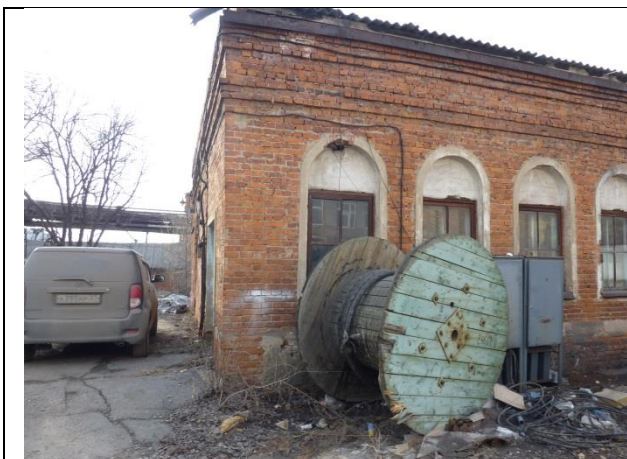
Фото 1.1. Центральная распределительная подстанция, лит. О
