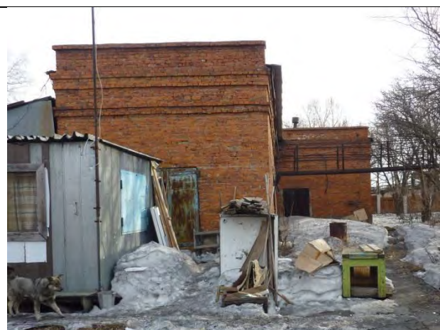
Фото 1.2. Центральная распределительная подстанция, лит. О
